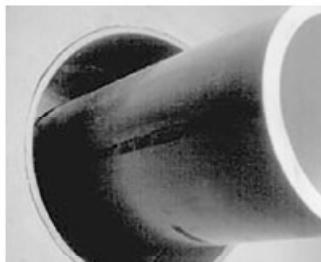
Отцентрируйте трубу в заранее просверленном стеновом отверстии или в гильзе. Убедитесь, что трубопровод имеет опору с обеих сторон. Он должен быть максимально прямой на расстоянии 60 см до и после уплотнителя. Цепные уплотнения не предназначены для поддержания веса трубы.
