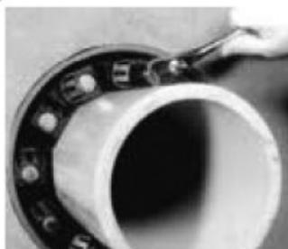
Начиная с положения 12 часов, затяните любой болт по часовой стрелке. Затягивайте только вручную. Продолжайте по часовой стрелке.
